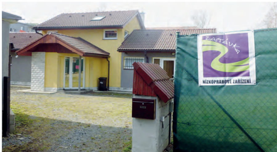
Budova služby „Zastávka“
